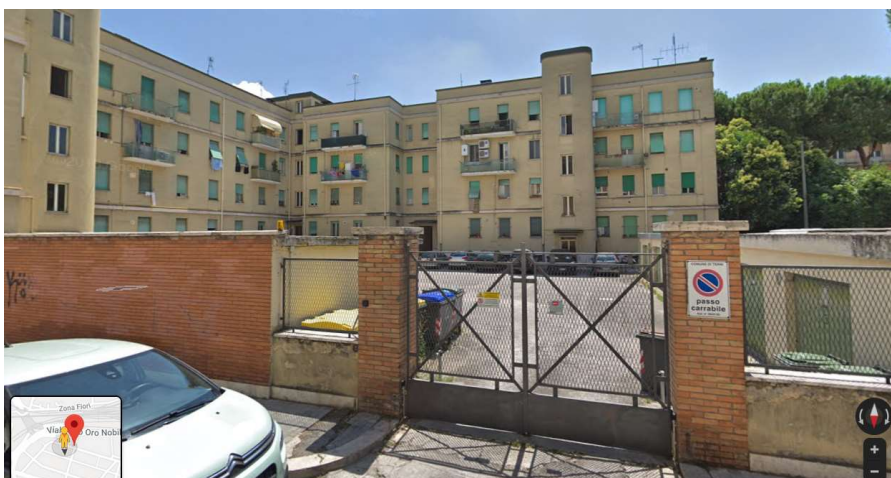
Figura 2 -vista cancello di ingresso all'area di proprietà
