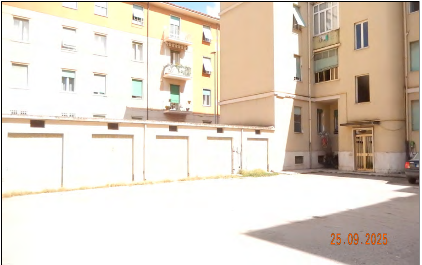
Foto n.3 corpo B -vista panoramica
