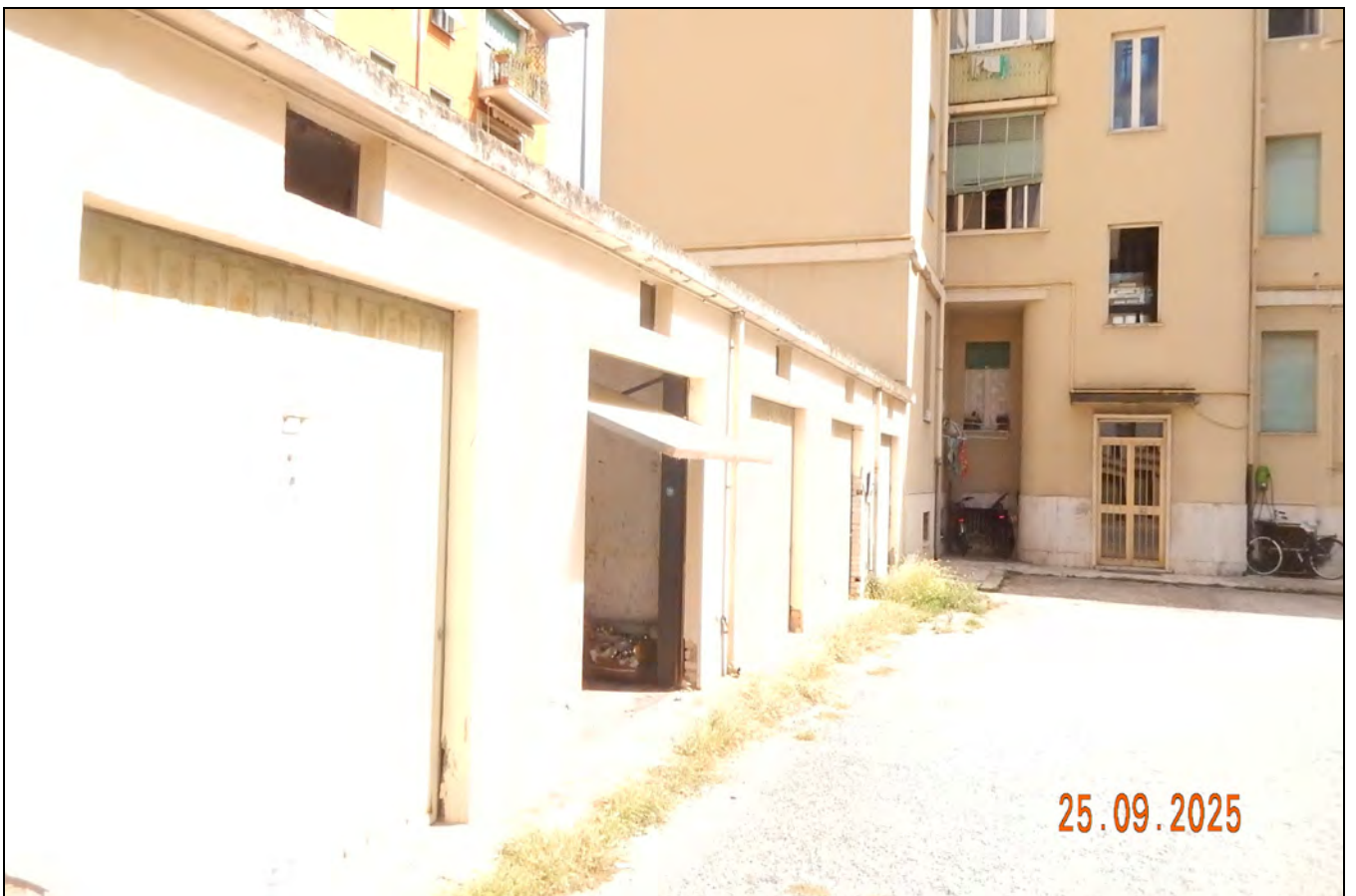
Foto n.2 corpo B -vista panoramica
