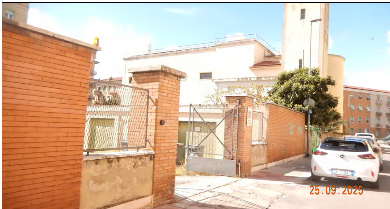
Vista ingresso area da Via Ludovico Antonio Muratori
