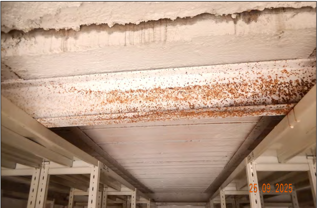
Foto interne corpo A solaio di copertura in putrelle e tavelloni
