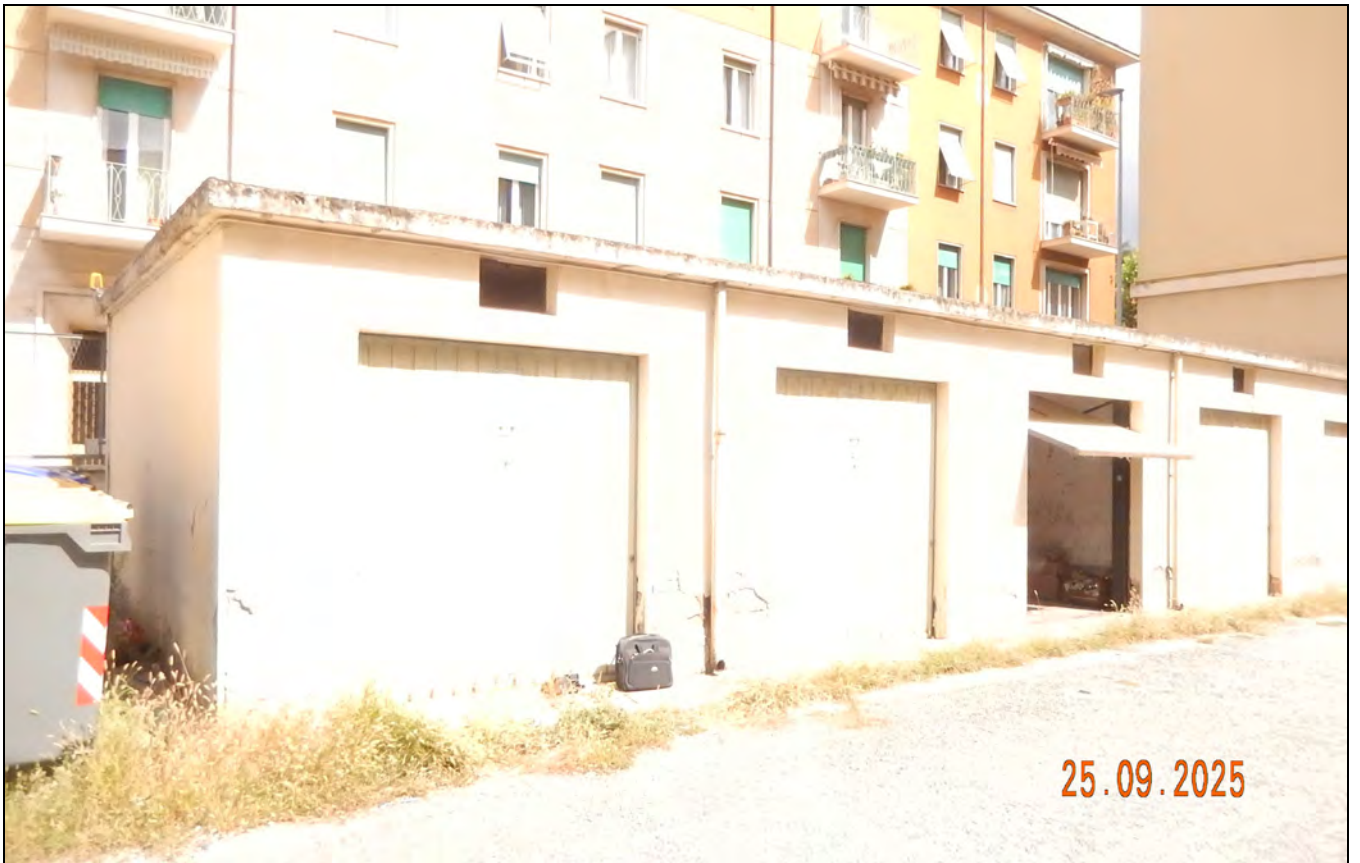
Foto n.1 corpo B -vista lato ingresso
