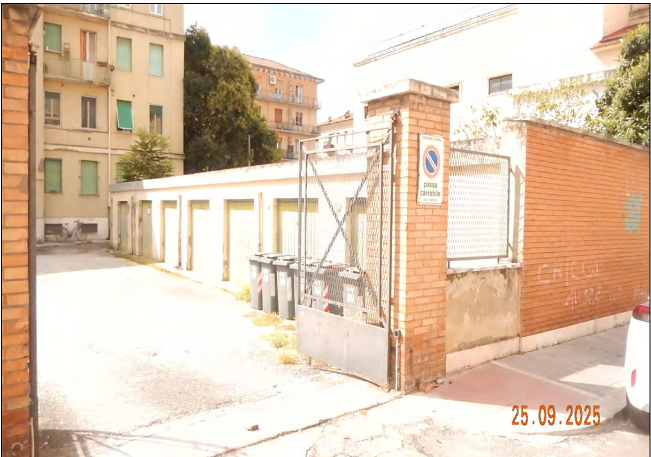
Foto n. 3 corpo A -vista lato ingresso carrabile
