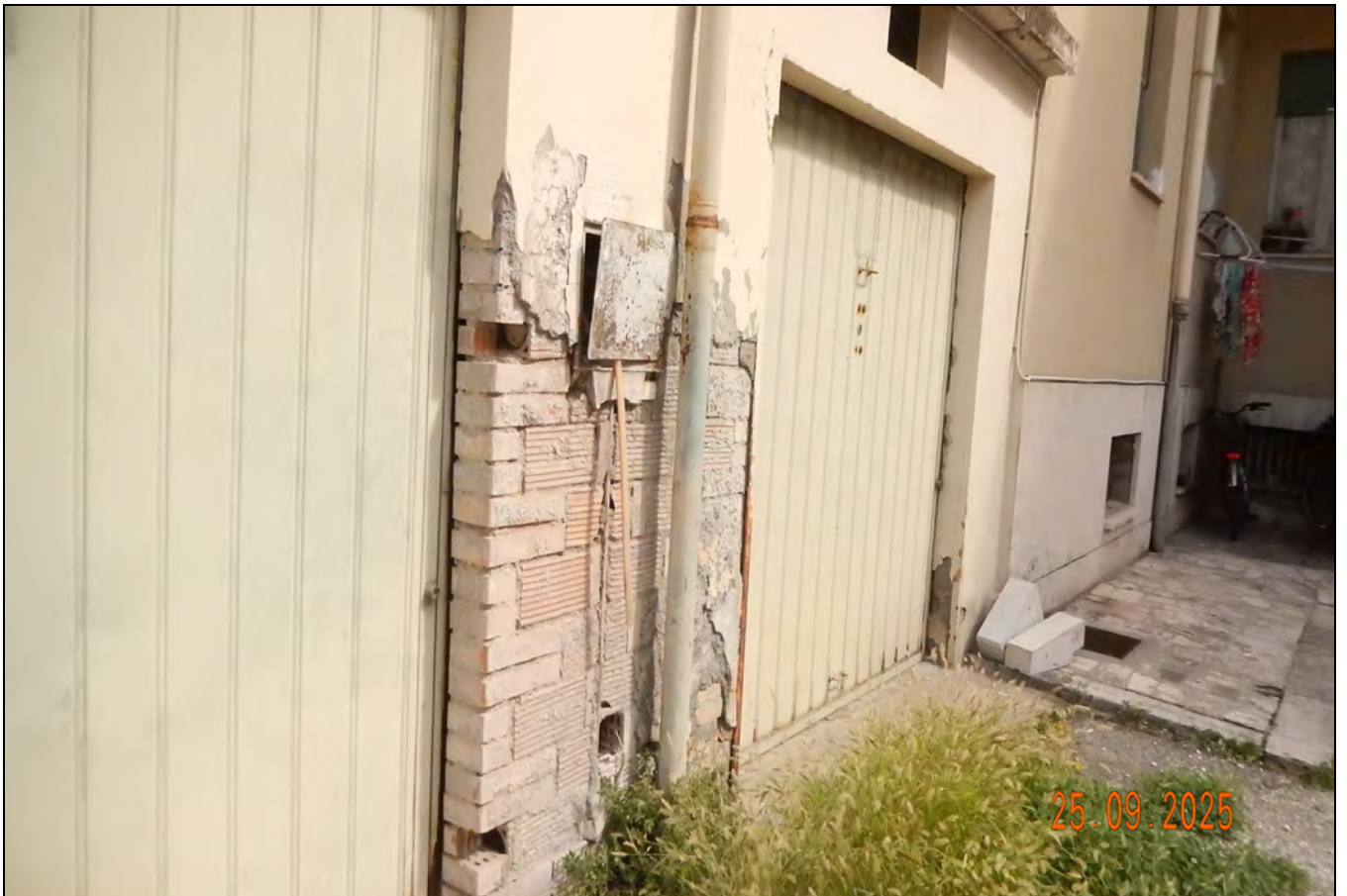
Foto n.4 corpo B -vista lato terminale
